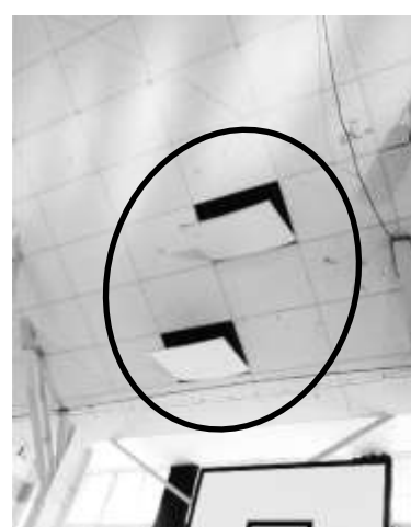
三和中学校（体育館天井）
