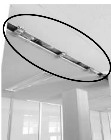
安塚中学校（校舎廊下天井）
