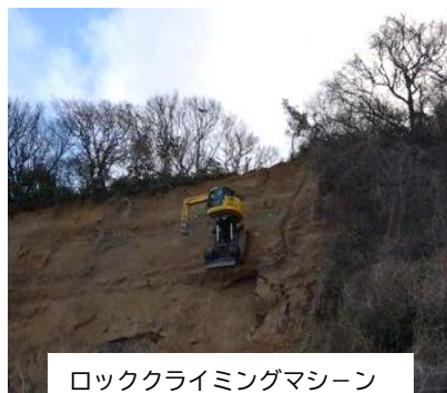
ロッククライミングマシンの稼働状況【1/4(木)15時撮影】
