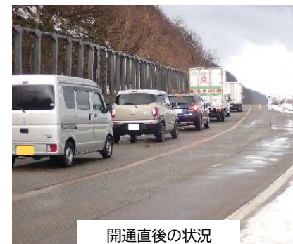
開通直後の状況【1/27(土)10時撮影】
