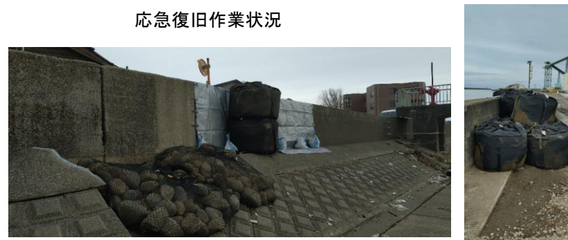
1月3日応急復旧完了
