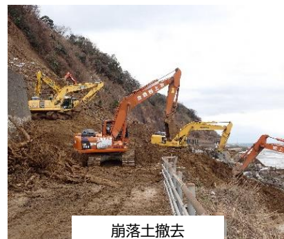
崩落土撤去【1/9(火)13時撮影】
