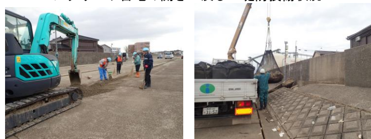
応急復旧作業状況
