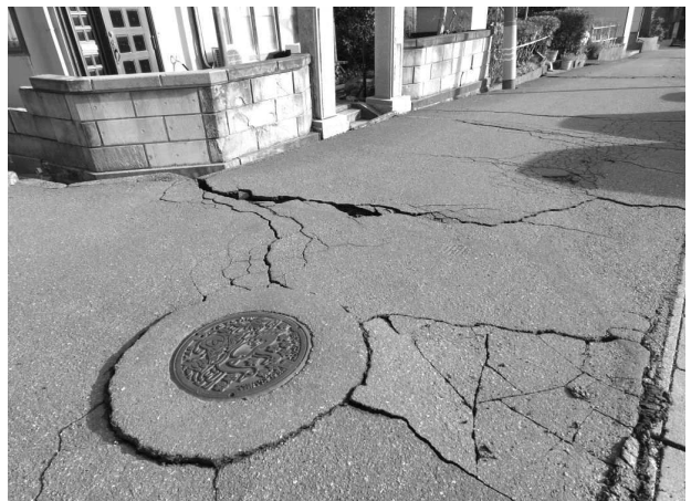
〔 被災状況 (令和6年1月) 〕 道路舗装、側溝の損傷
