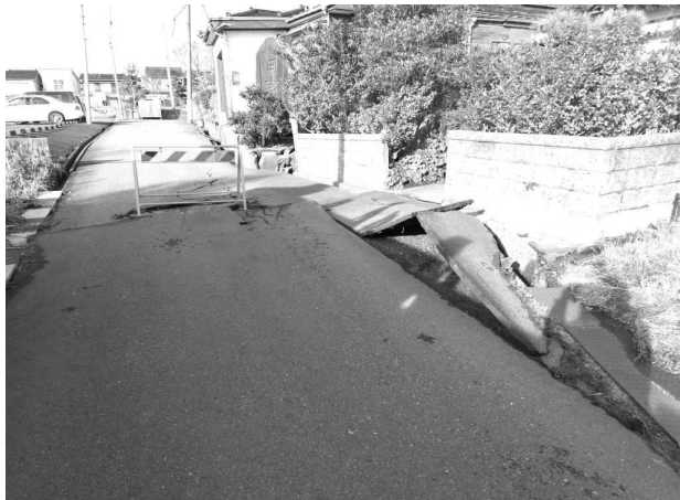
〔 被災状況 (令和6年1月) 〕 道路舗装、側溝の損傷
