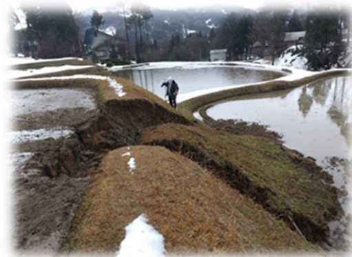
地震により崩落した農地法面
