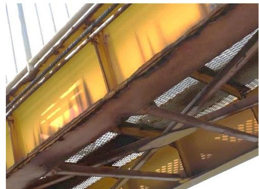
主構造部の腐食
