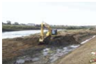
関川河道掘削 (鴨島地先)
