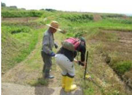
電気柵設置作業中
