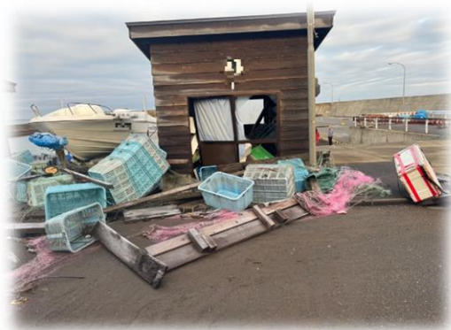
津波により損傷した倉庫と散乱した漁具
