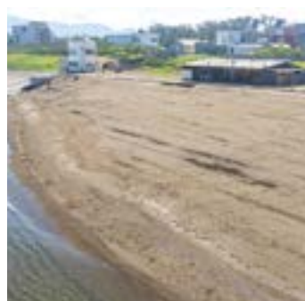
▲海岸侵食が深刻となっていた鵜の浜海水浴場。砂を搬入してならし、砂浜の面積を確保して開設。
