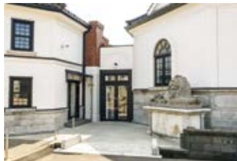
▲ライオン像のある館（旧直江津銀行） 入口前のライオン像は、高橋達太の要請により柏崎市の石工・小川 よしひろ 田廣が制作しました。
