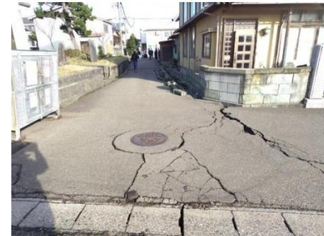
地震により被災した市道西本町四丁目2号線は、応急復旧工事後、国の災害査定により復旧事業が確定した。本復旧工事は、6月から着手し、降雪前の11月下旬までに完了する予定である。
