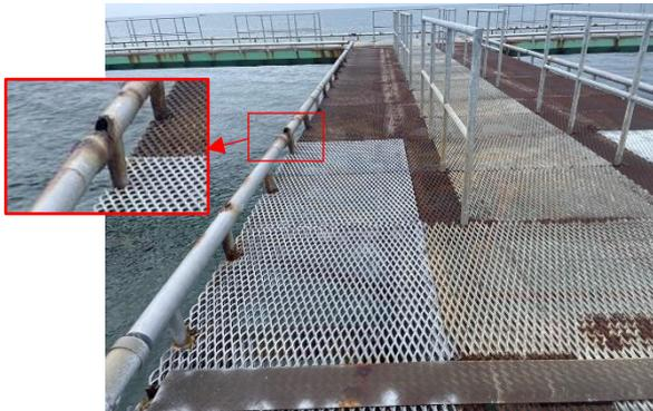
手すりの設置状況、竿受台・床版の腐食
