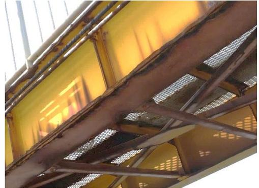
主構造部の腐食
