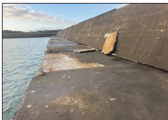
コンクリートが剥離した大湊漁港
