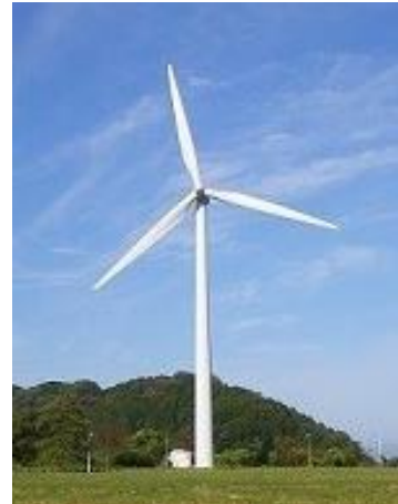
風力発電施設 3 号機
