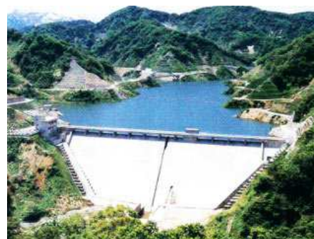
正善寺ダム（上正善寺地内）
