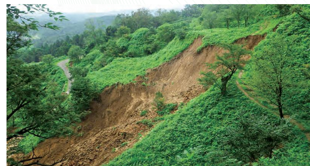
国史跡 春日山城跡での土砂崩落 (2016・平成28年7月)
