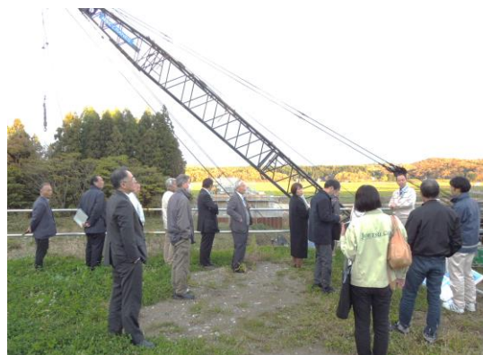
▲本郷建設現場を視察
