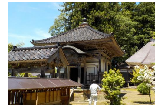
▲善徳寺経堂の外観 ・登録有形文化財（登録：平成 27 年）
