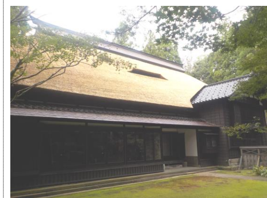
▲林富永邸(富永家住宅 主屋)の南面外観 ・市指定文化財(登録:平成14年)
