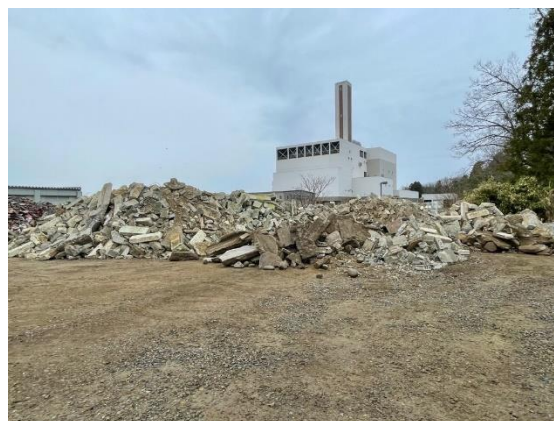
仮置場開設後（コンクリートがら）
