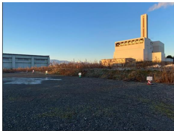
仮置場開設前
