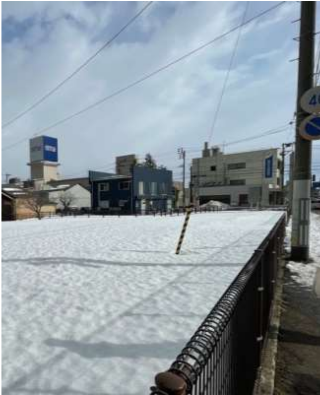
【敷地内電柱支線】
