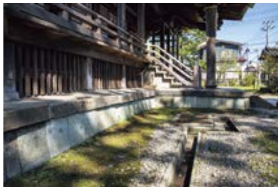
笏谷石が使われている拝殿の基礎部分。美しい緑色が特徴的です。
