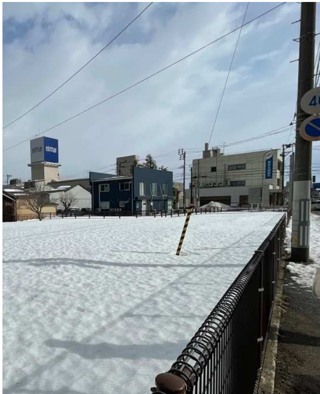
【敷地内電柱支線】
