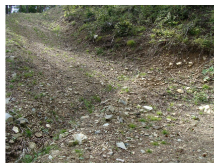
素掘りによる横断溝
