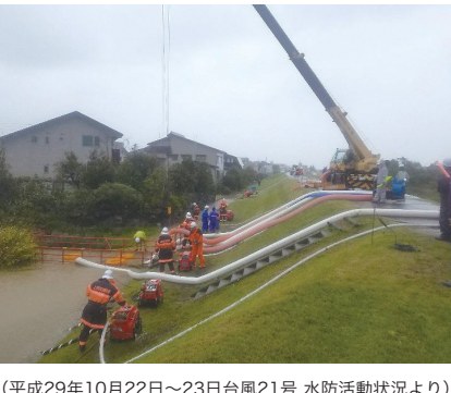
（平成29年10月22日～23日台風21号水防活動状況より）
