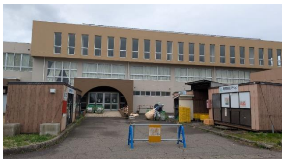
▲カルチャーセンターの体育館入口に設置されている資源物常時回収ステーション
