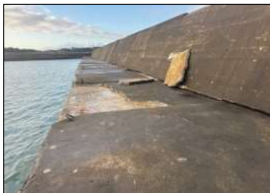
コンクリートが剥離した大湊漁港
