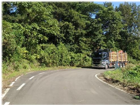
林道の整備・維持修繕
