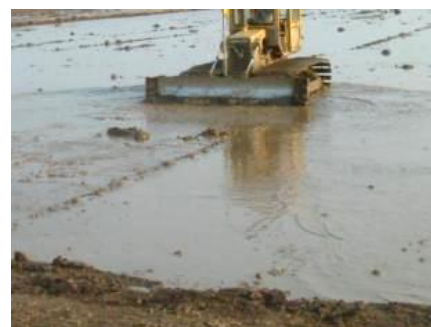
ブルドーザーを用いた湛水整地
