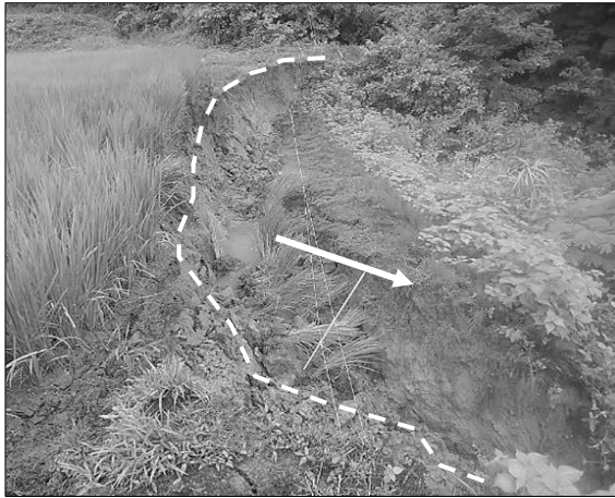
畦畔崩落（大島区仁上地内）
