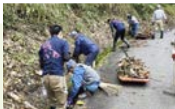
11月 牧区 農道の側溝整備
