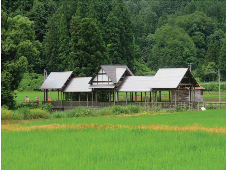
9 仁上ほたる公園（ほたる橋）
