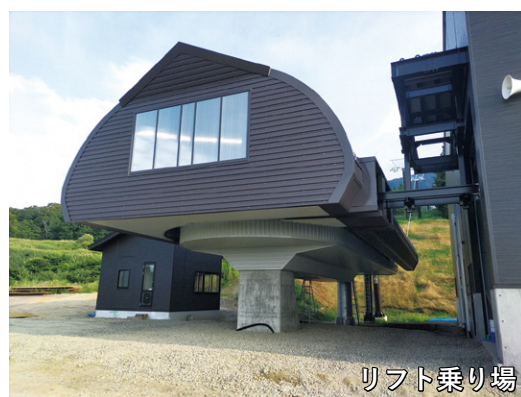
新第2リフト山麓駅舎
