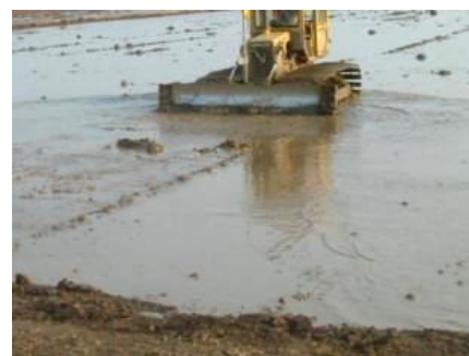
ブルドーザーを用いた湛水整地
