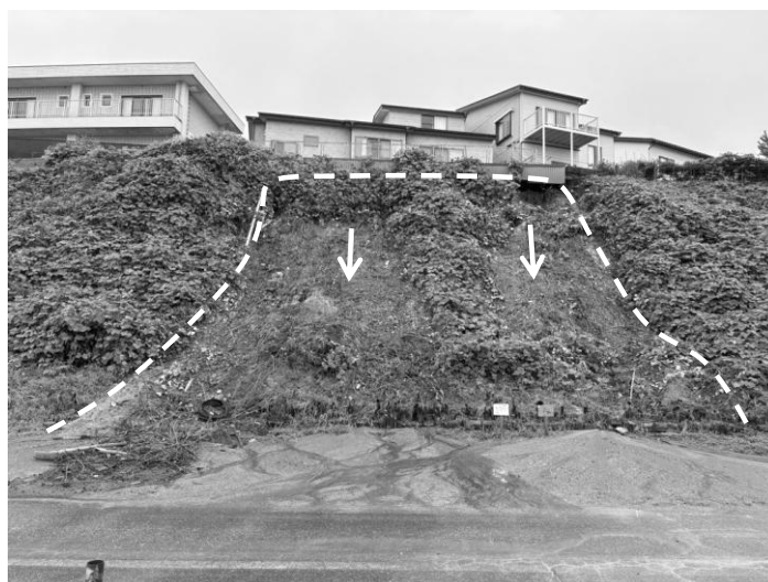
〔 被 災 状 況 〕 斜面崩落(五智五丁目)
