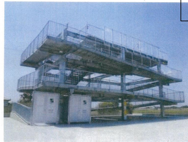
静岡県内にある津波避難タワー 高さ7m～8m 収容人数100人～ 工事費5千万～8千万
