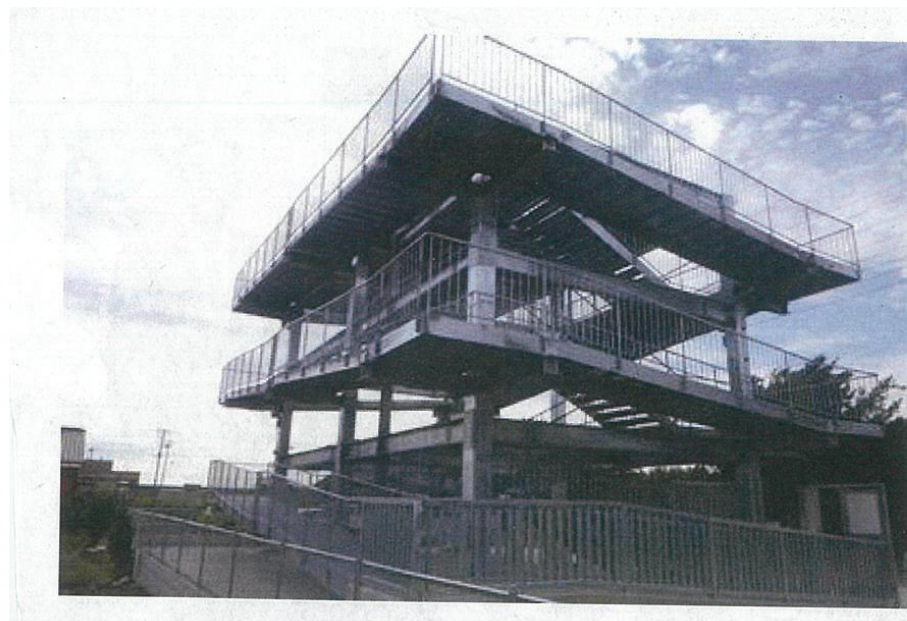
静岡県内にある津波避難タワー 高さ7m～8m 収容人数100人～ 工事費5千万～8千万
