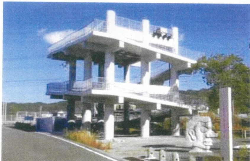
静岡県内にある津波避難タワー 高さ7m～8m 収容人数100人～ 工事費5千万～8千万
