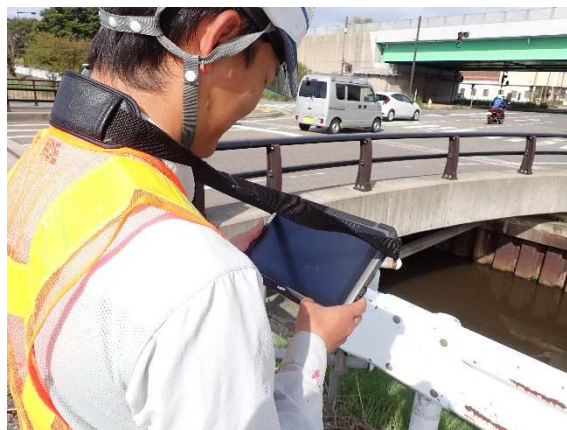
図 タブレットシステムを活用した点検
