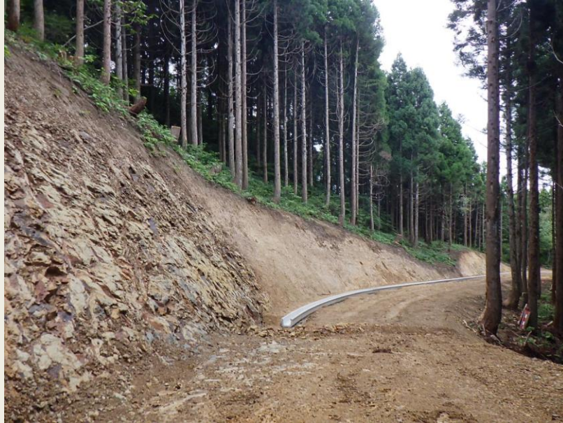
掘削後の法面
