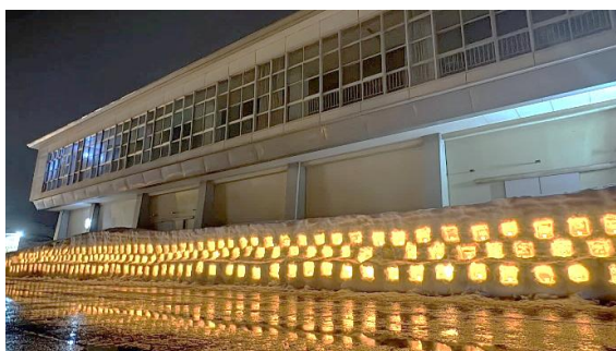
▲浦川原体育館
