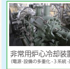
+ 高圧代替注水ポンプ (制御電源不要)
