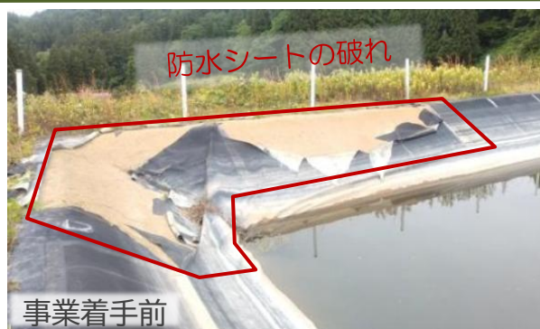
ため池堤体の防水シートの修繕
