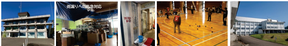
築60年超となり著しく老朽化した牧区総合事務所
