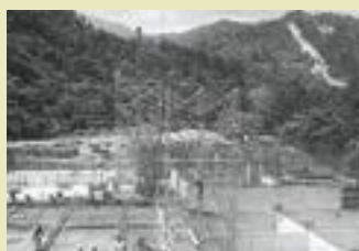
建設中の城山浄水場
