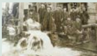
南城浄水場での地下水くみ上げ
