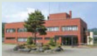
正善寺浄水場
