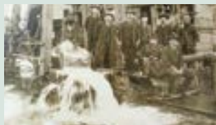
南城浄水場での地下水くみ上げ
