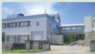
柿崎川浄水場
