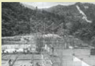
建設中の城山浄水場
