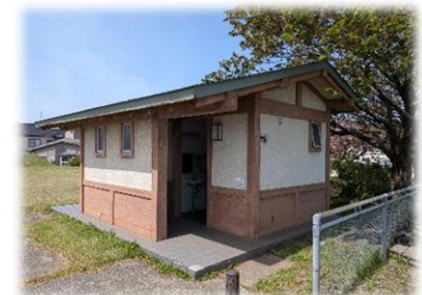
潟町中央公園トイレ(潟町駅)
