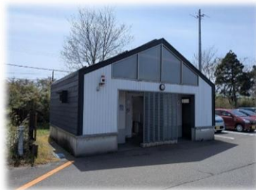
犀潟駅トイレ
