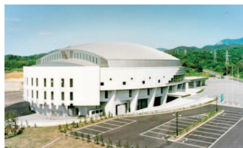
柿崎総合体育館（かきざきドーム）
