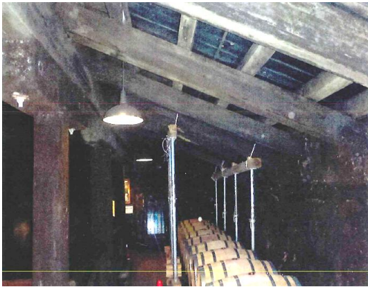
◀ 着工前 (仮補強)
