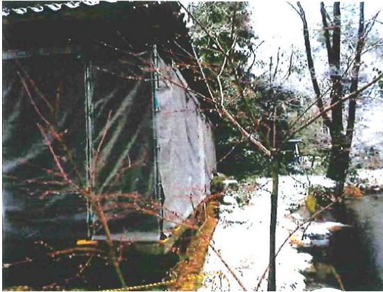
▲北側 下屋 補強仮設（外部）
