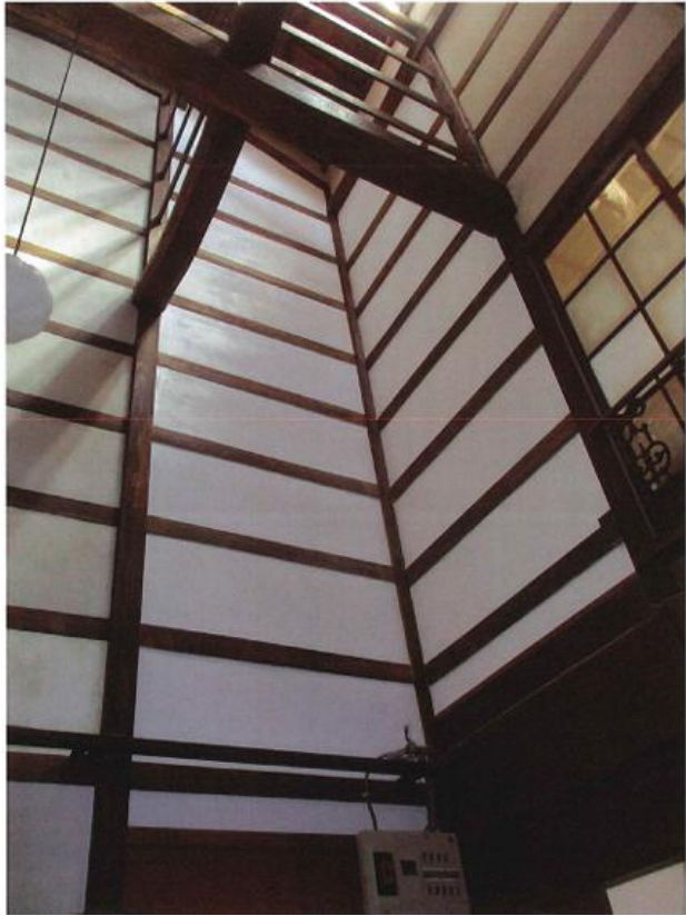
▲建物内部 吹き抜け部分 補修後
