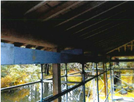
▲北側 下屋 補強仮設（内部）
