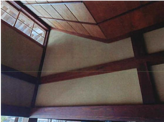
▲ゲンカンノマ 南面 修繕後
