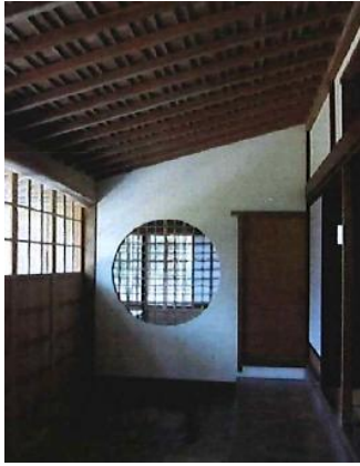
▲ドイン（北縁側）丸窓 修繕後
