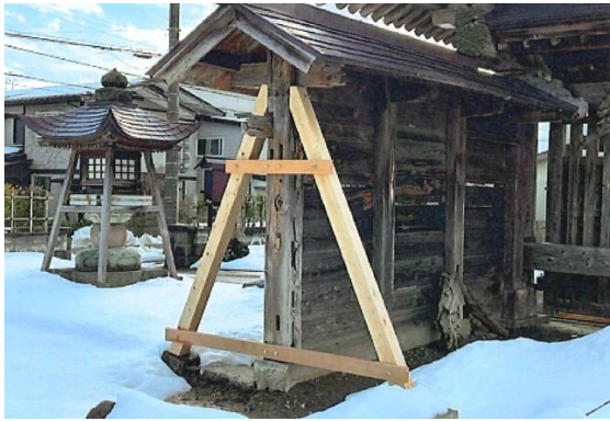
▲支え木による補強
