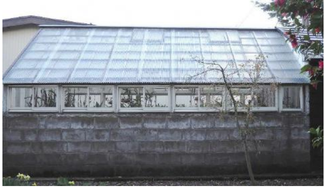
▲改修前：当初の板ガラス屋根が経年で破損し、その上に塩ビ波板を張り付けていた。
