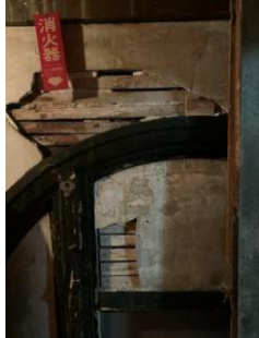
▲経年で破損し雨漏りしていた 漆喰壁の補修
