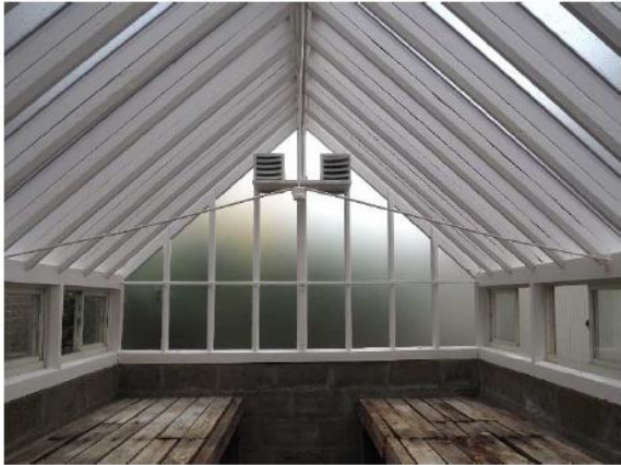
▲改修後：塩ビ波板を耐候性樹脂版に葺き替え、換気機能も新設した。
