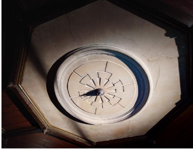
▲新技術を用いて落下防止対策を施した漆喰天井
