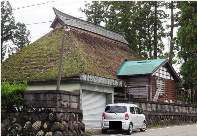
▲北妻面茅葺屋根 施工前
