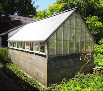
▲改修前：当初の板ガラス屋根が経年で破損し、その上に塩ビ波板を張り付けていた。
