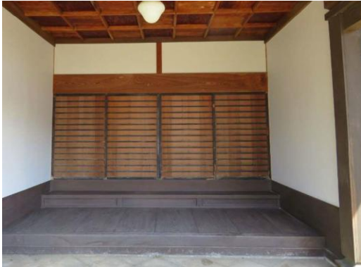
▼復旧後の様子
