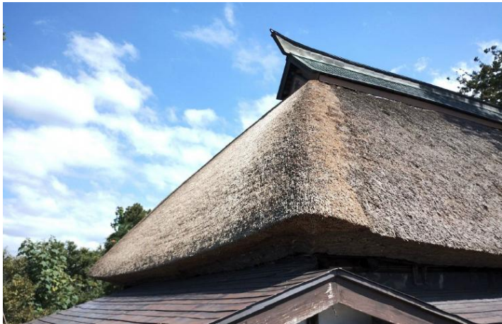
▲北妻面茅葺屋根 施工後▼
