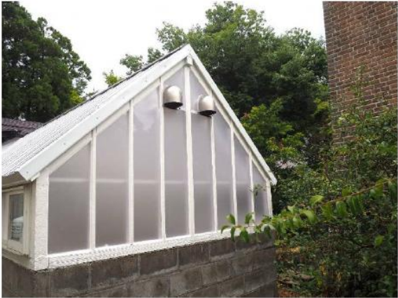
▲改修後：塩ビ波板を耐候性樹脂版に葺き替え、換気機能も新設した。
