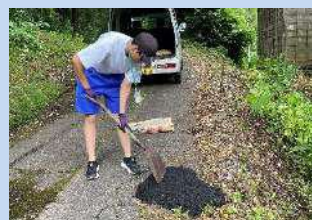
道路の穴埋めの様子
