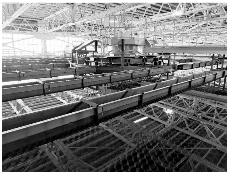
▲城山浄水場の高速凝集沈澱池
