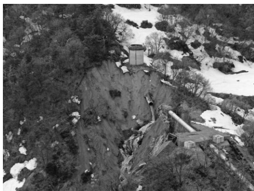
▲県営高田発電所の水圧管路破断状況 (新潟県提供)
