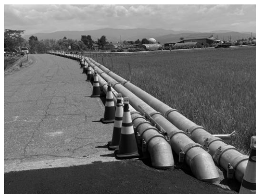
▲上越妙高駅消雪井戸から城山浄水場 までの配管
