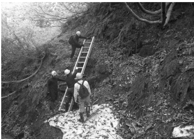
〔散策道のはしご修繕〕
