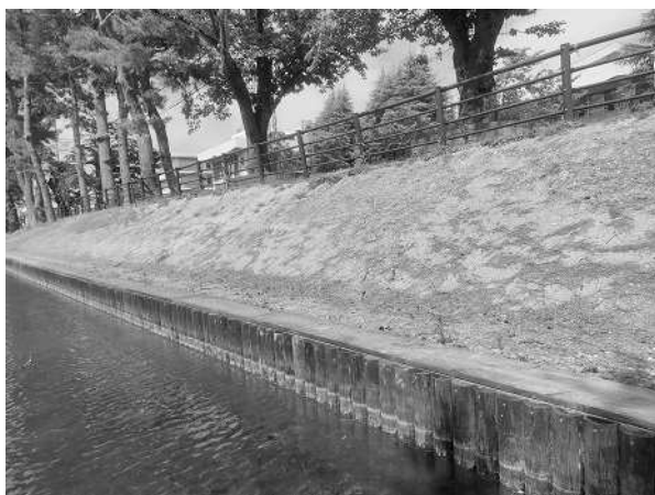
内堀護岸更新（高田城址公園）
